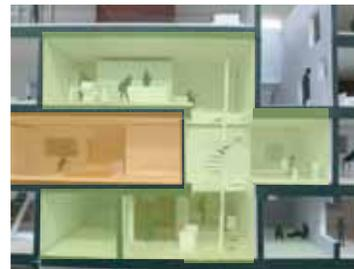
緑色部分の住戸は、オレンジ色の住戸によって、住戸内に凹凸がつくりだされている。隣接する住戸（オレンジ色の住戸）を構成する床、壁、天井によって、緑色の住戸は、垂直方向に分節され、空間に視覚的連続が生み出されている。
