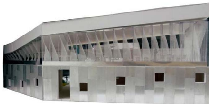
廊下棟の外壁は金属とガラスで構成させる。
