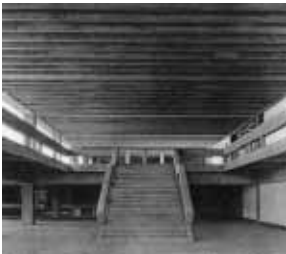
画 2-1-1 倉吉市庁舎 地階市民ホール
