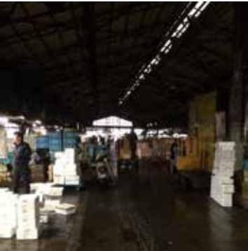
■屋根のみの架構
