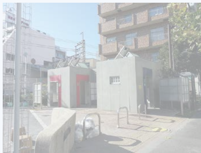
2. 平成 23 年完成の公衆便
